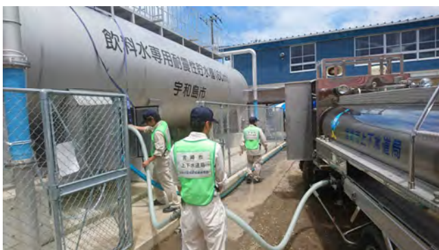
7月23日 飲料水専用耐震性貯水槽へ補水（三間中学校）
